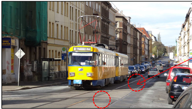
Schachtdeckel sichtbar im landwärtigen Gleis
