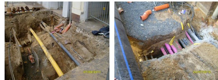
Beispiel für Auswechslung von Abwasser-HAL vom Kanal bis Grundstücksgrenze
